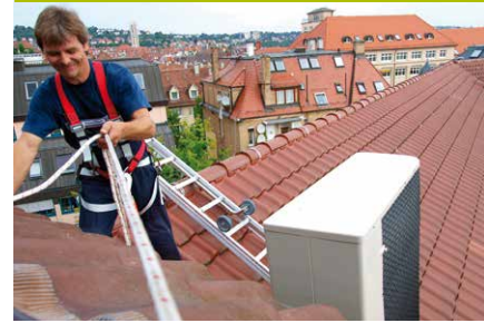
Schanz GmbH Kälte- und Klimatechnik
