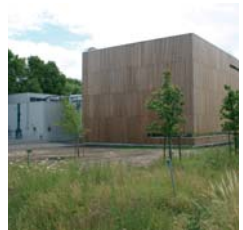
Umweltfreundliches Blockheizkraftwerk im Scharnhäuser Park
